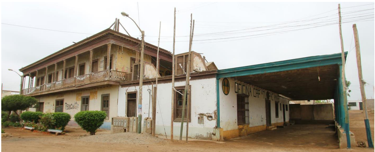
Antigua casa principal de la hacienda Casablanca. Después de la Reforma Agraria de 1969 se transformó en la Cooperativa Agracias de Producción Túpac Amaru N° 3. Imagen: propia, 2018.
