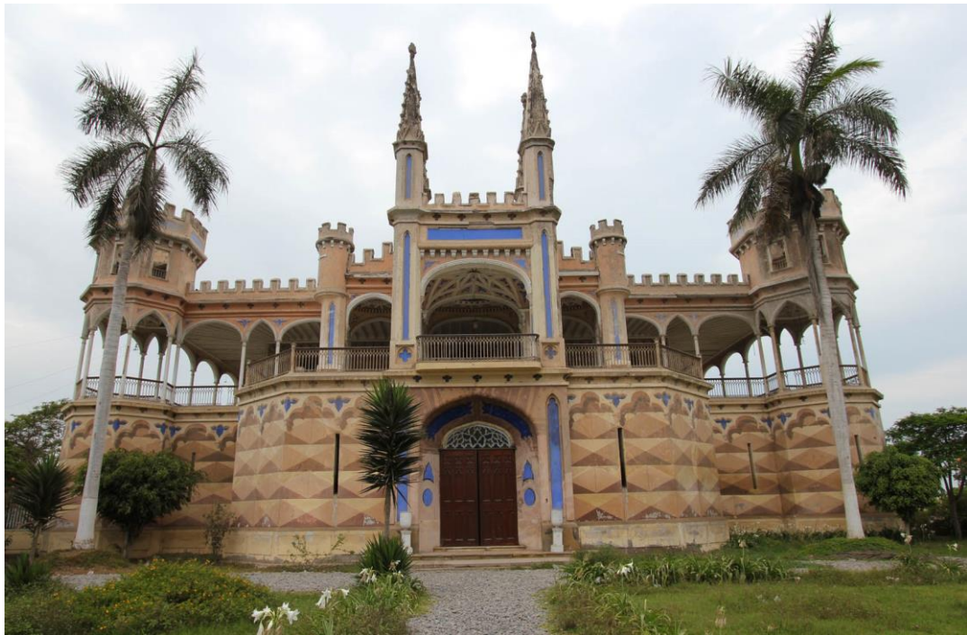
Casa principal de la antigua hacienda Unanue: arquitectura neogótica en la campiña cañetana, resuelta con ladrillos, adobes y quincha. La pintura mural tiene un notable efecto de trampantojo. Imagen: propia, 2019
