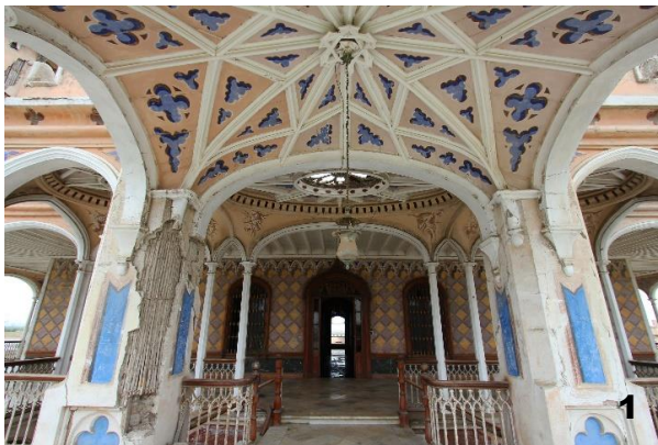
Casa principal de la antigua hacienda Unanue. 1. Galería alta en la fachada principal donde entrega la escalera de dos idas en forma de huso. Los pilares son telares de quincha y la bóveda es encamonada y de crucería estrellada. 2. Cubierta de uno de los cuatro miradores dispuestos en las esquinas de la vivienda. Tienen planta octogonal sustentada en gráciles pilares de madera que sostienen una bóveda de crucería plana, encamonada y estrellada. Imagen: propia, 2020.
