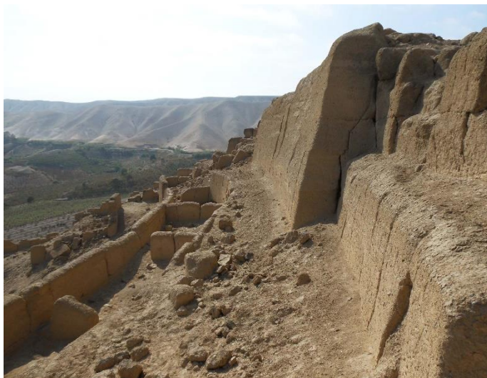
Ungará: sector oeste con aterrazamientos que generan sendas epimurales y habitaciones rectangulares alargadas, cuya función debe ser establecida a través de las excavaciones arqueológicas pertinentes. Imagen: propia, 2016
