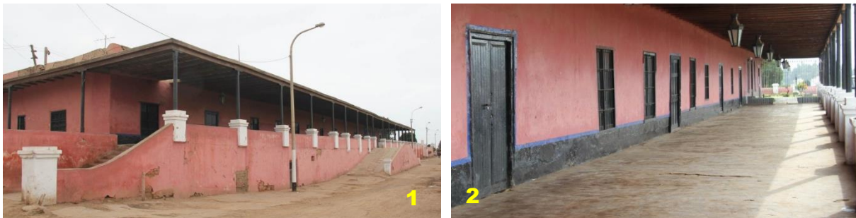
San Vicente de Cañete: casa principal de la antigua hacienda Montalbán. 1. Vista exterior 2. Amplia galería frontal delimitada exteriormente con pies derechos de madera y cubierta plana sustentada en cuarterones. Imagen: propia, 2017.
