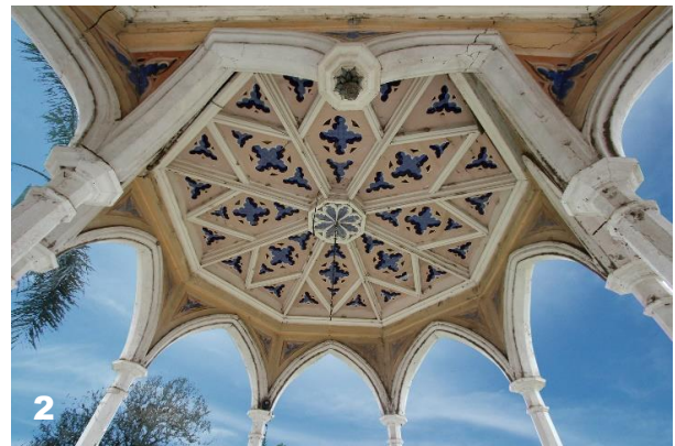
Casa principal de la antigua hacienda Unanue. 1. Galería alta en la fachada principal donde entrega la escalera de dos idas en forma de huso. Los pilares son telares de quincha y la bóveda es encamonada y de crucería estrellada. 2. Cubierta de uno de los cuatro miradores dispuestos en las esquinas de la vivienda. Tienen planta octogonal sustentada en gráciles pilares de madera que sostienen una bóveda de crucería plana, encamonada y estrellada. Imagen: propia, 2020.
