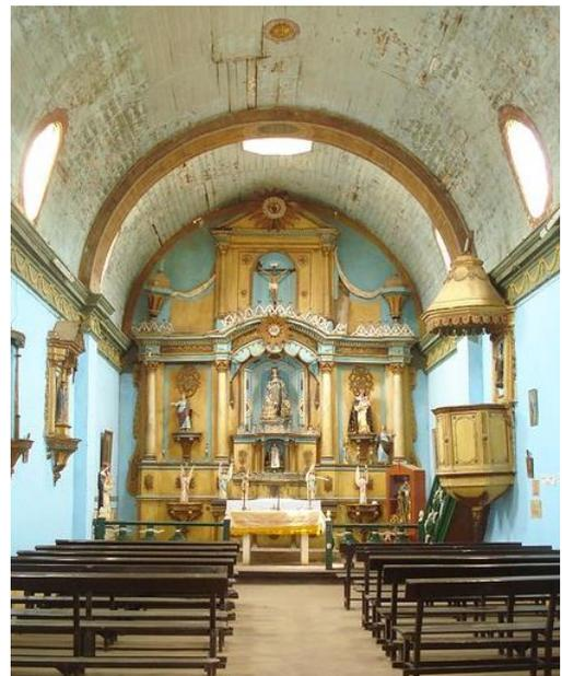
En el tramo de la capilla mayor ha sido colocada una linterna octogonal de madera que acompaña en la iluminación a los óculos abiertos en sendos lados de los muros de la nave.
