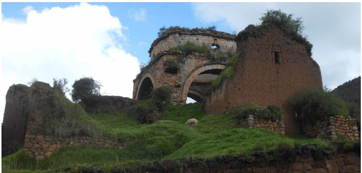
Mara, iglesia de San Matías. Sector correspondiente a las ruinas del presbiterio construido con adobes y del crucero fabricado con sillares.
