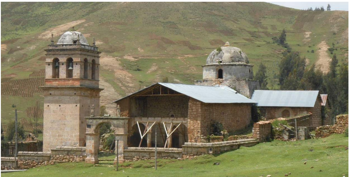
Patahuasi, iglesia de Santiago Apóstol. Al haber perdido el imafrente la torre ha quedado exenta y la arquería del sotacoro ha quedado visible desde el exterior. Al fondo se alza la cúpula sobre el crucero. Imagen: Samuel Amorós, 2017.
