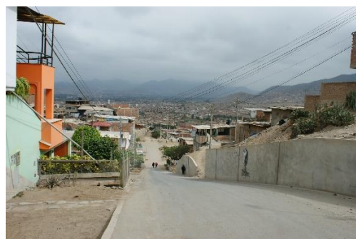
Figura N°26: pendientes no reglamentarias en Villa Alejandro
