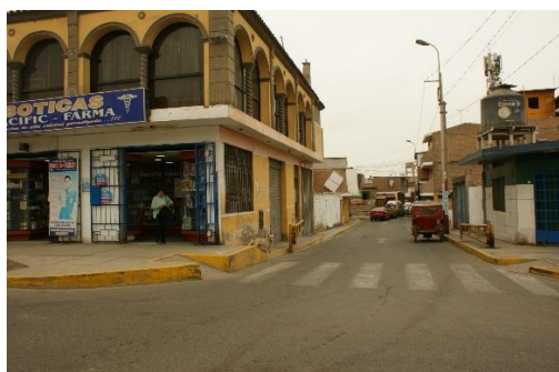
Figura N°25: discontinuidad de calles en el Cercado
