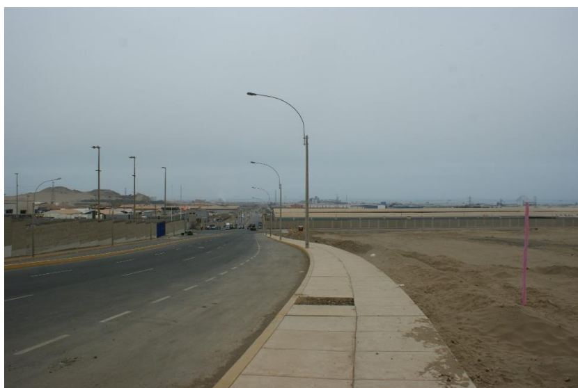
Figura N°29: vista panorámica desde Macrópolis hacia el litoral
