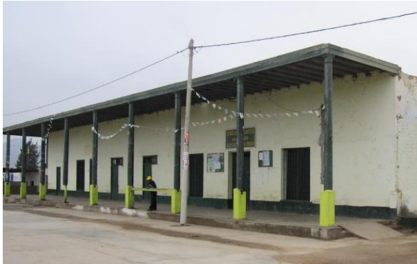
Sector de las rancherías de la ex-hacienda Vilcahuaura, edificado a finales del siglo XIX. Actualmente funcionan allí diversas dependencias administrativas.
