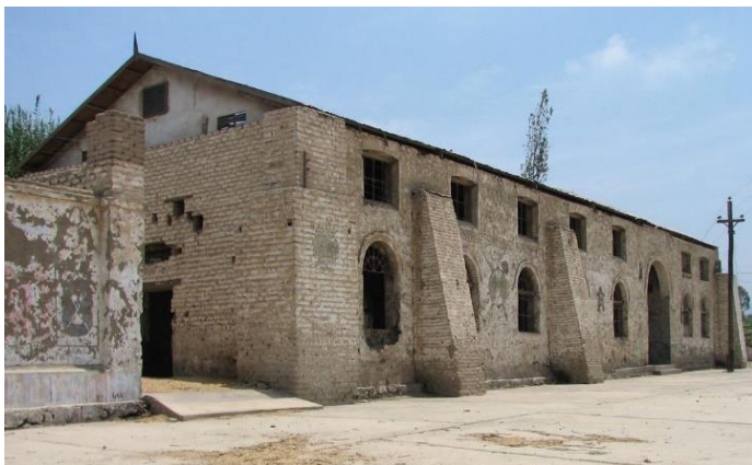
Desmotadora de la antigua hacienda San José de Rontoy. Imagen: propia, 2019
