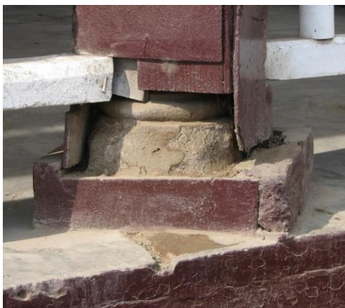
Basa de la columna que sustentaba originalmente la galería frontal de la vivienda principal en la hacienda El Ingenio. Imagen: propia, 2019
