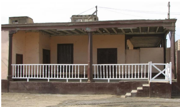
Casa principal de la antigua hacienda El Ingenio. Imagen: propia, 2019
