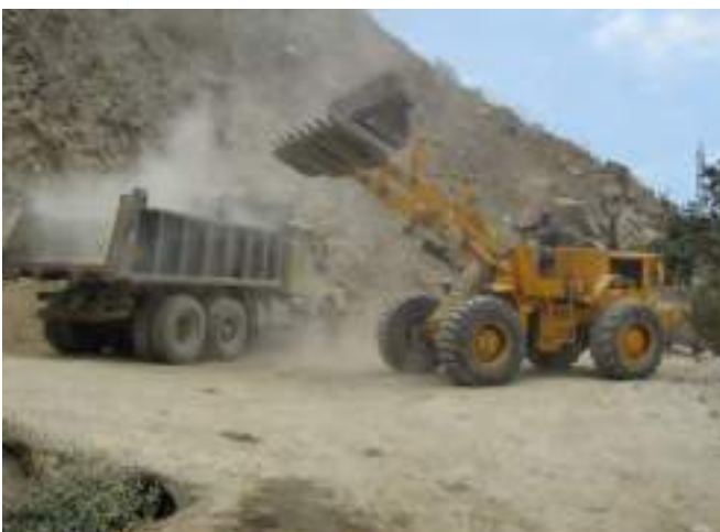
La magnitud de los trabajos obligó a la necesaria utilización de maquinaria pesada para el movimiento de tierras y traslado de los materiales de desecho fuera de la carretera.
