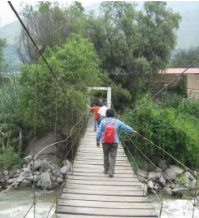
Puente colgante ubicado a la altura del anexo de Palle, distrito de Santa Eulalia de Acopaya.
