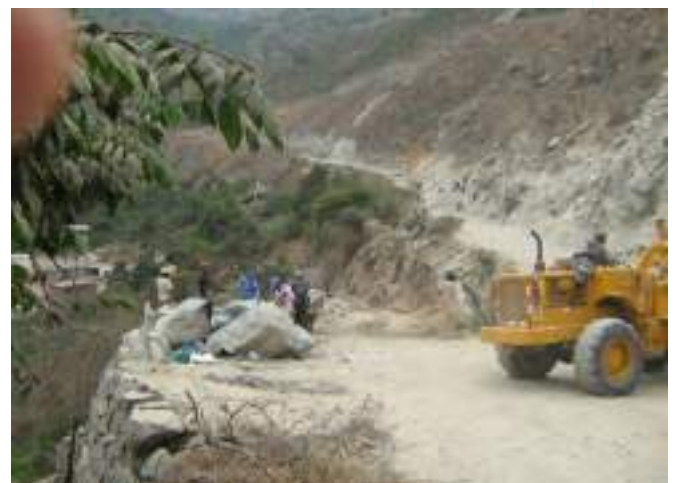
La magnitud de los trabajos obligó a la necesaria utilización de maquinaria pesada para el movimiento de tierras y traslado de los materiales de desecho fuera de la carretera.
