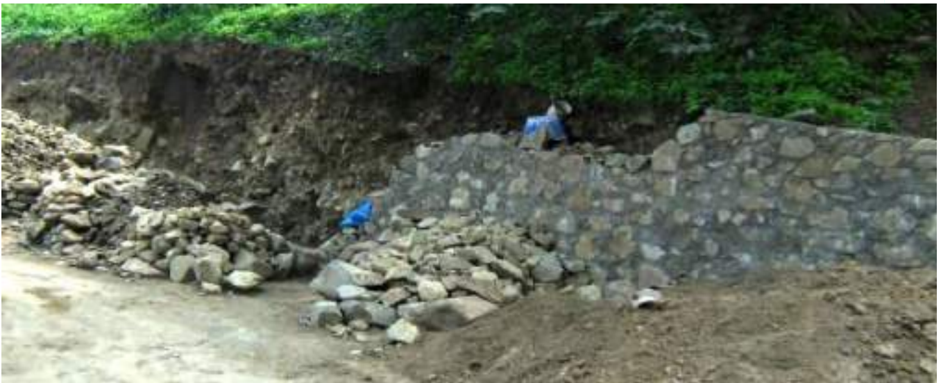
Los iniciales trabajos obligaron a la construcción de pircas y muros de contención para permitir el ensanchado de la carretera.
