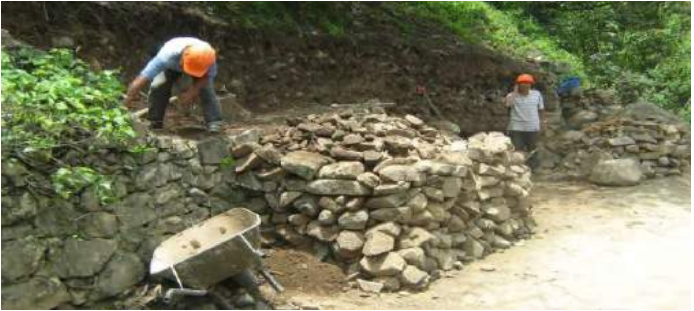
Los iniciales trabajos obligaron a la construcción de pircas y muros de contención para permitir el ensanchado de la carretera.
