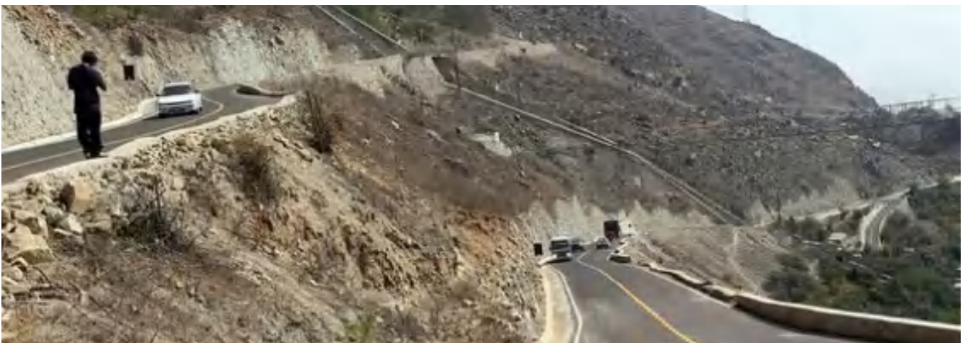
Vista de la carretera asfaltada. Es notoria en esta parte del recorrido la falta de forestación de los taludes del cerro.
