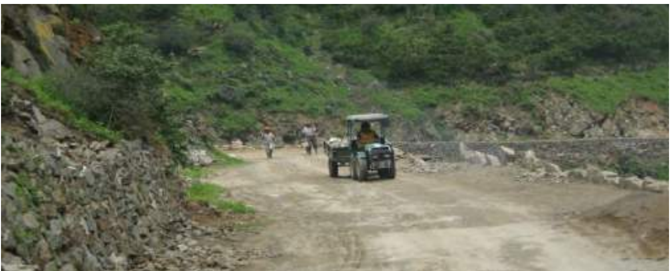
Nótese el tamaño e importancia de la obra de ensanchamiento de la carretera, construcción de muros de contención y un parapeto en la totalidad de un recorrido.
