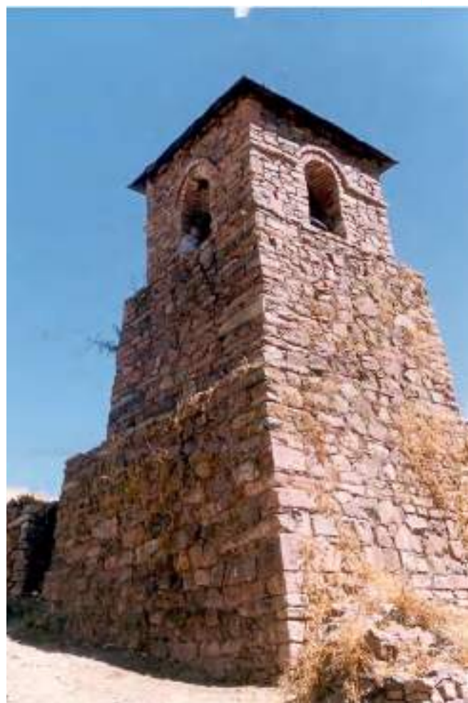
Foto de la torre de la iglesia de Chauca
