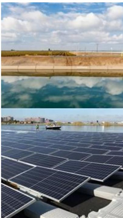
La colocación de paneles solares sobre canales evitaría la pérdida de agua y mejoraría la recolección de energía de los paneles.
