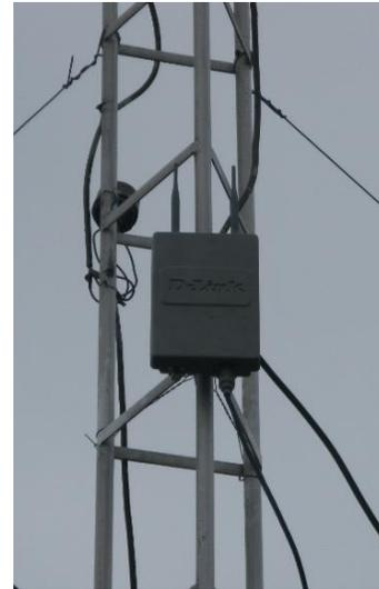
**Figura 9. Access Point D-link DWL2700AP Montado sobre Torre Ventada**
