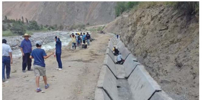
Trabajos de recuperación del canal de captación de agua para uso agrícola y doméstico efectuado por el Sindicato de Trabajadores de Construcción Civil.
