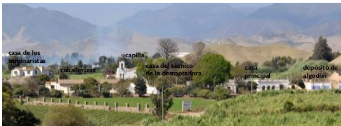
Antigua Hacienda San José de Rontoy. Vista panorámica, sector oeste. Imagen: Carmen Rivera Portilla, 2015.
