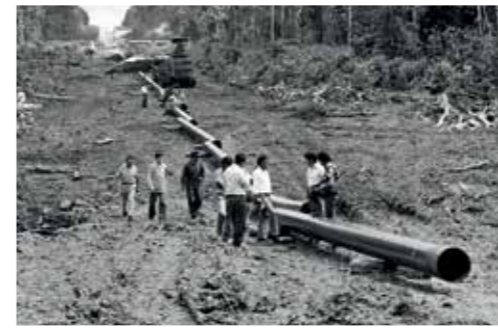
El oleoducto norperuano, considerado una de las más grandes obras de ingeniería peruana (1977)
