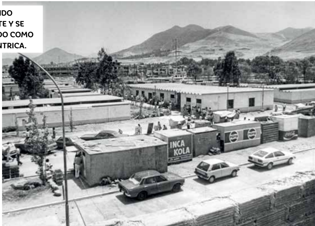
El campus de la Universidad Ricardo Palma en sus inicios. Se aprecian los módulos con techos de canalón.
