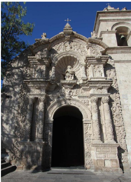
Arequipa, iglesia de San Juan Bautista de Yanahuara, ubicada a un costado de la plaza principal de distrito. Su construcción culminó en el año 1750, conservando como edificación originaria de mediados del siglo XVIII el arco del coro alto ornamentado con follajería y hojarasca, así como su portada de pies, elaborada con sillar y profusamente decorada con diseños esculpidos de forma planimétrica. Imagen: Sandra Negro, 2015
