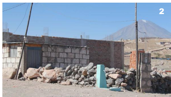
1. Camiones estacionados a un lado de la vía, ofreciendo la venta de sus cargas de sillares, 2. Vivienda económica en las inmediaciones de la autopista Arequipa-La Joya, edificadas con bloques de sillar. Imágenes: Sandra Negro, 2015.
