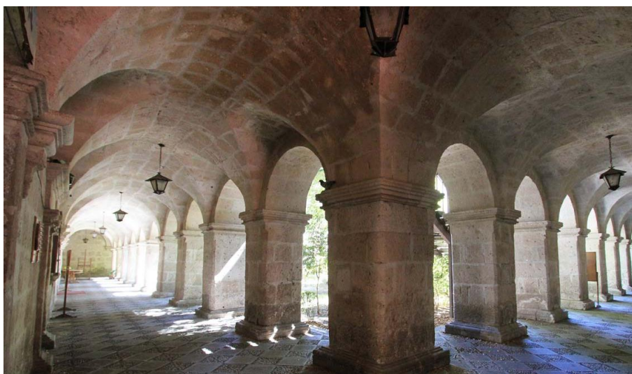
Arequipa, claustro mayor del antiguo convento de San Agustín, edificado con pilares que sustentan bóvedas de arista, todo ello empleando la piedra sillar. En 1828 se creó la Universidad Nacional de San Agustín, que continúa funcionando al presente en los antiguos claustros agustinos. Imagen: Sandra Negro, 2015.
