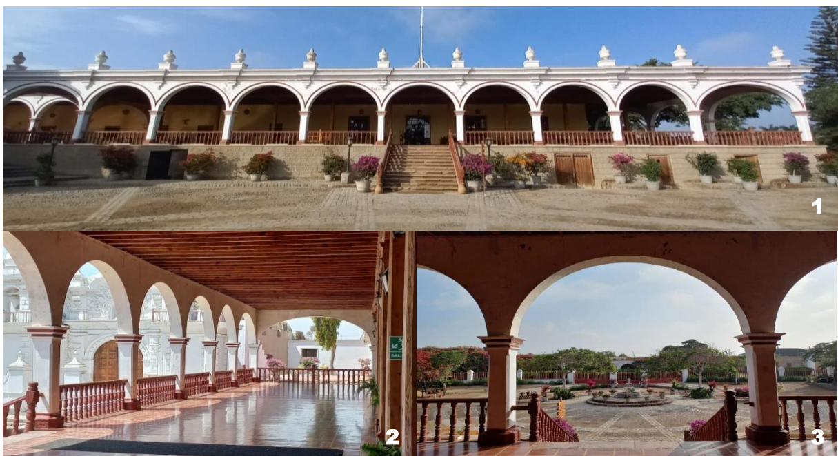
1, 2 y 3. Casa restaurada, fachada principal, galería, patio principal con pileta. Imágenes: propias, 2022.
